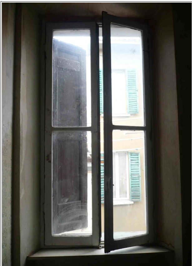
FOTO 11, 12 e 13. Esempi di infissi che non presentano problemi di stabilità
