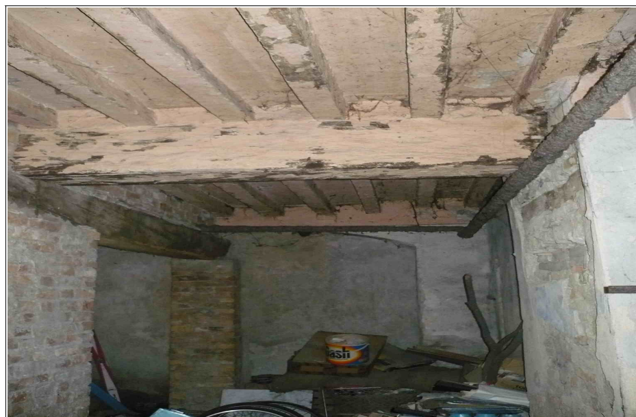
FOTO 6,7 e 8. Particolari dei solai in legno
