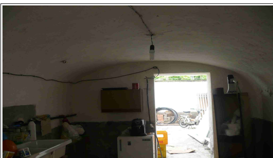
FOTO 5. Corridoio di collegamento tra i due cortili con soffitto a botte
