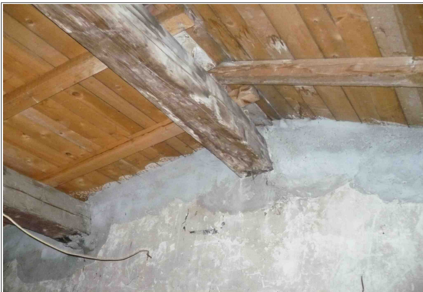
FOTO 9, 10 e 11. Particolari del tetto in legno e del cordolo di perimetro e di colmo in cemento armato
