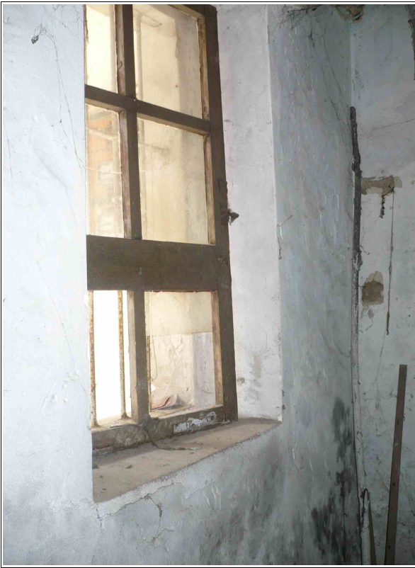
FOTO 14,15 e 16. Esempi di infissi pericolanti che sono stati rimossi
