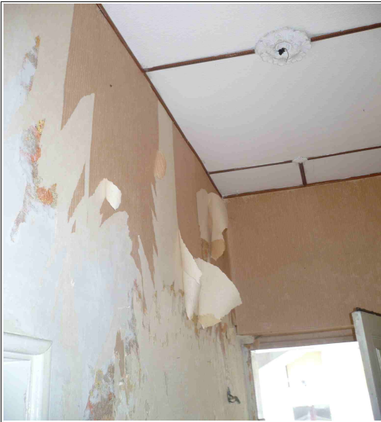
FOTO 32. Particolare delle superfici interne coperte da carta da parati da rimuovere
