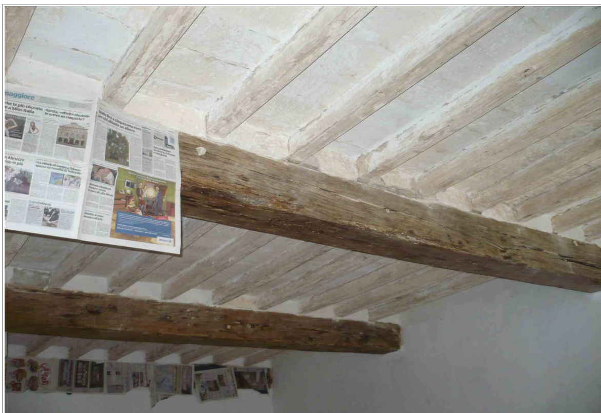
FOTO 36, 37 Esempi di spazi ristrutturati con recupero intonaco interno a civile, tinteggiatura, recupero della travatura lignea di sostegno del solaio, trattamento con impregnante
